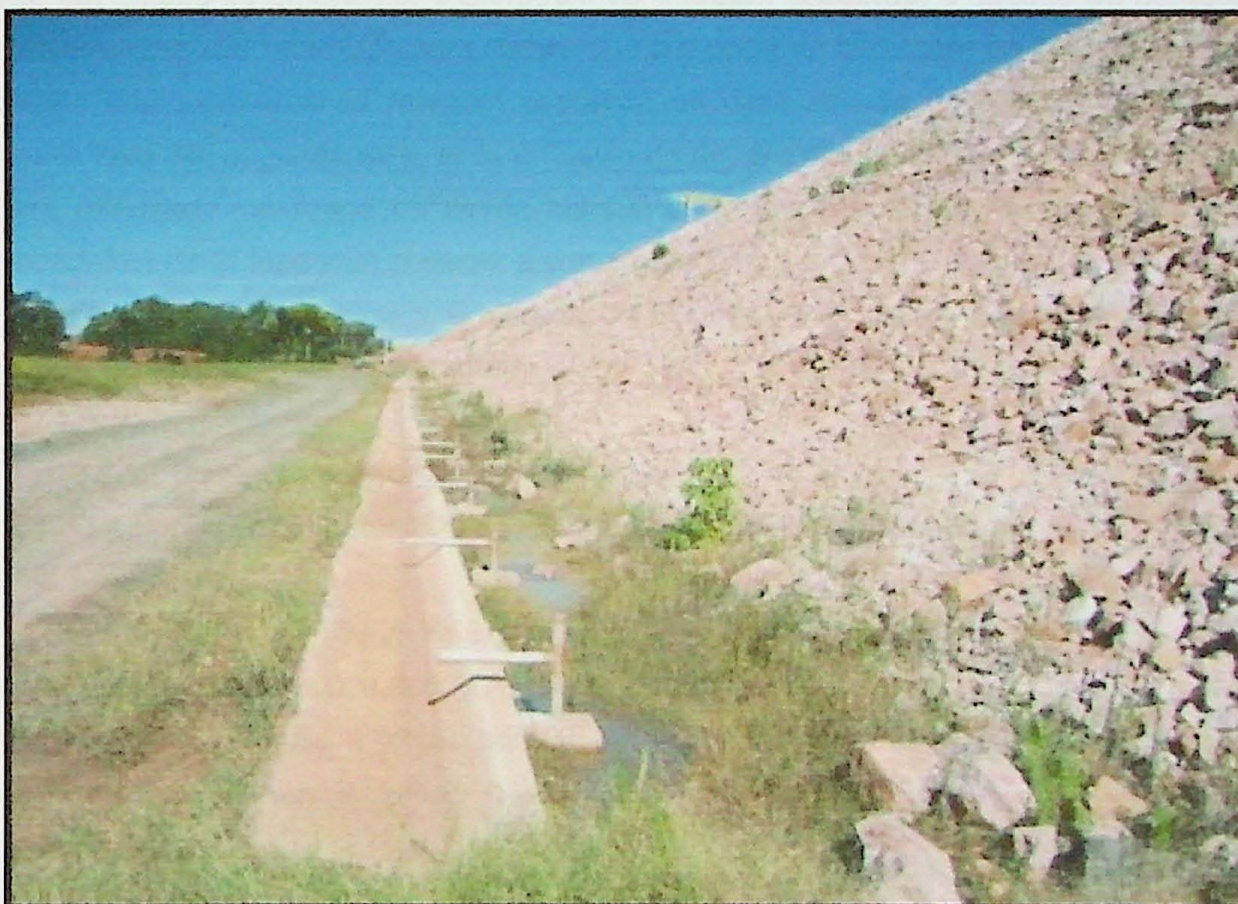
Foto 3 - Poços de alívio instalados
