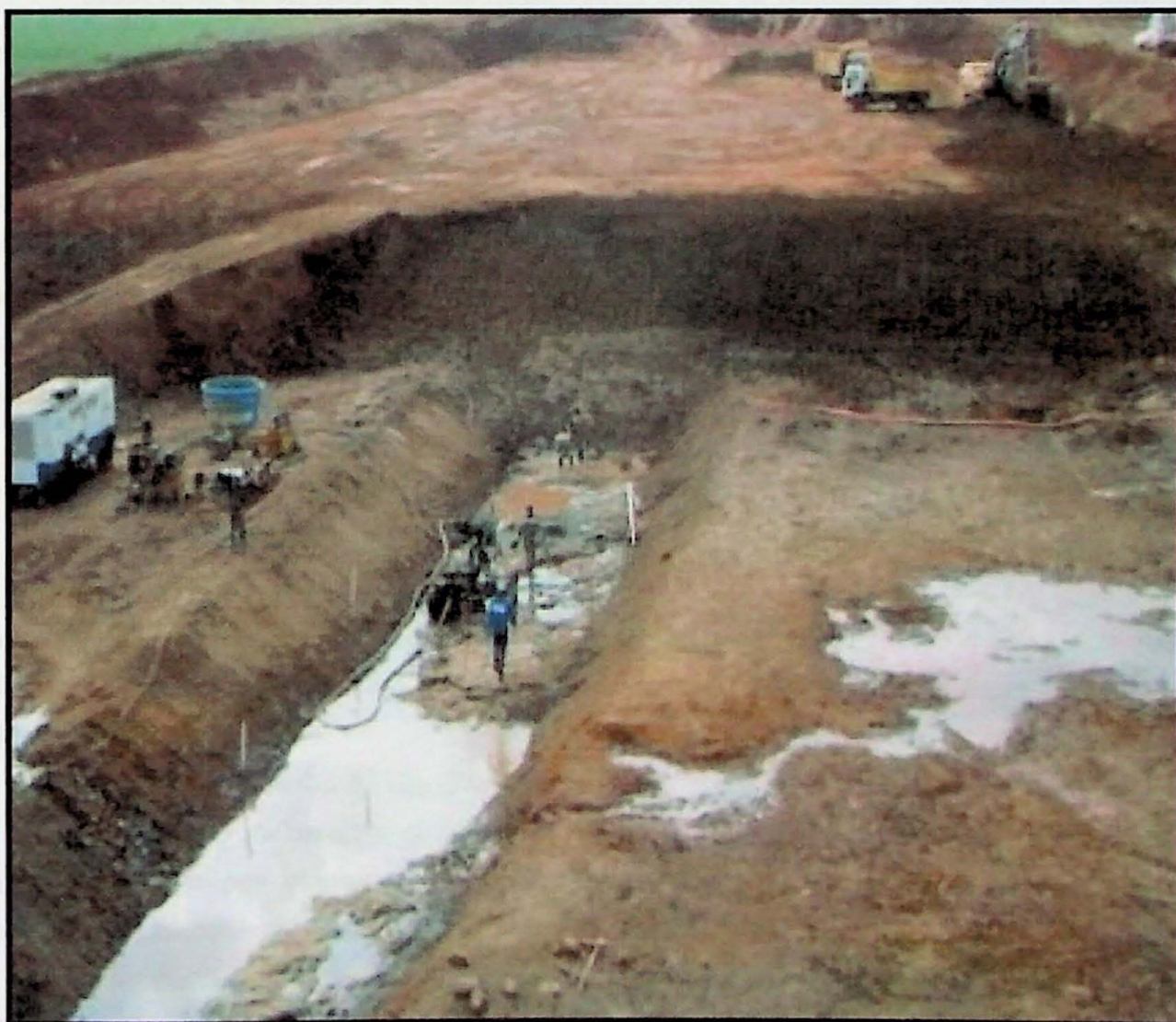
Foto 1 - Escavação para instalação do cut-off
