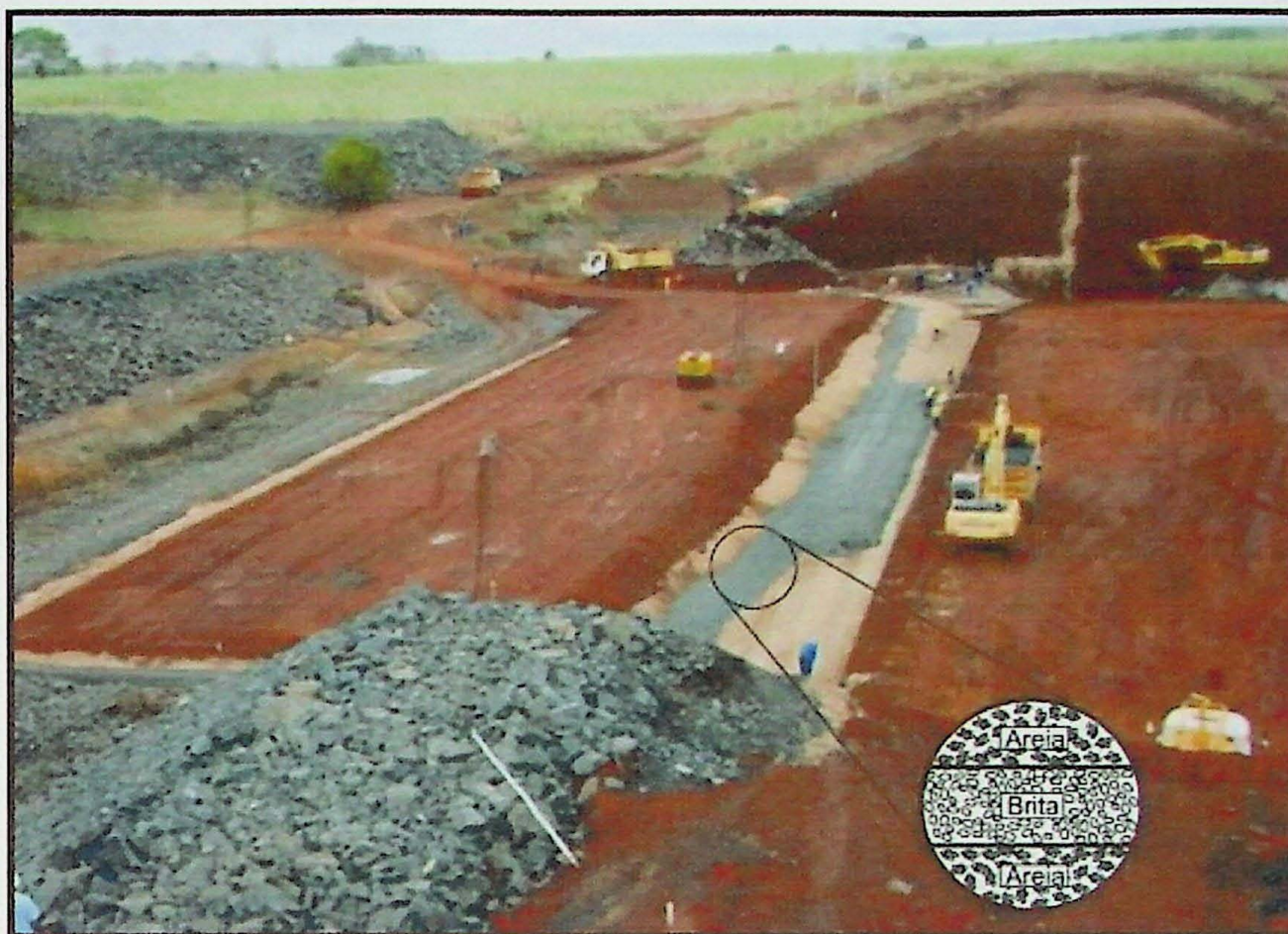
Foto 2 - Aplicação dos filtros em barragem de solo compactado
